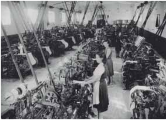
Fábrica RECASENS. La Pobla de Montornès (1922). RECASENS factory. La Pobla de Montornès (1922).
